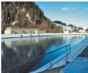
Bassin de compensation et centrale de Mottec
