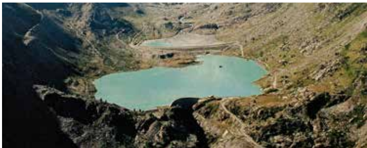
Bassin d'accumulation de Tourtemagne
