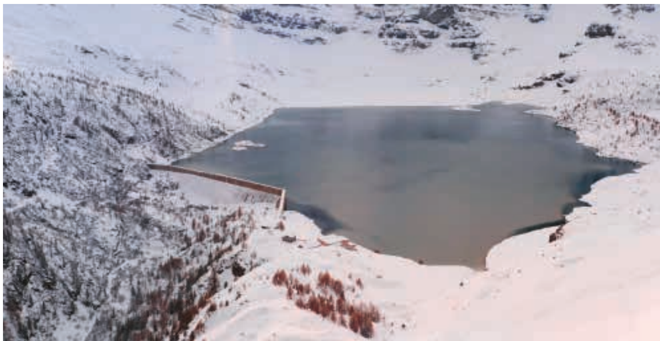
Le barrage de Salanfè.
