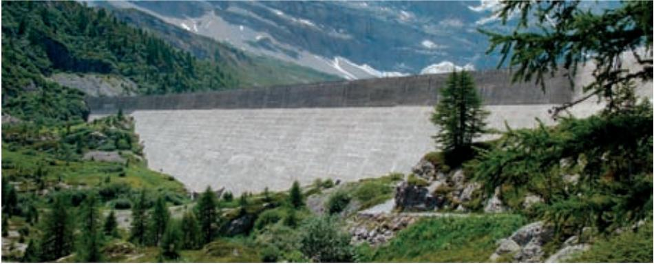
den Stausee durch das natürliche Gefälle eines 4,17 Kilometer langen Stollens und mit Hilfe von Pumpen in Clusanfe und Giétroz. Die Druckleitung zwischen dem Stausee und dem 1472 Meter tiefer gelegenen Kraftwerk Miéville hat drei Abschnitte mit einem Gefälle zwischen 0,5 Prozent und 94,62 Prozent. Zwischen 1991 und 1994 wurden am Becken Abdichtungsarbeiten durchgeführt.
