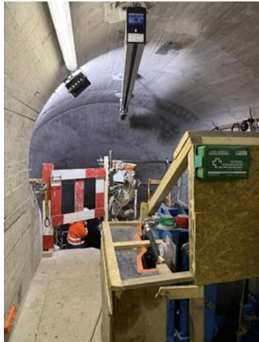
Accès supérieur du puits (treuil)
